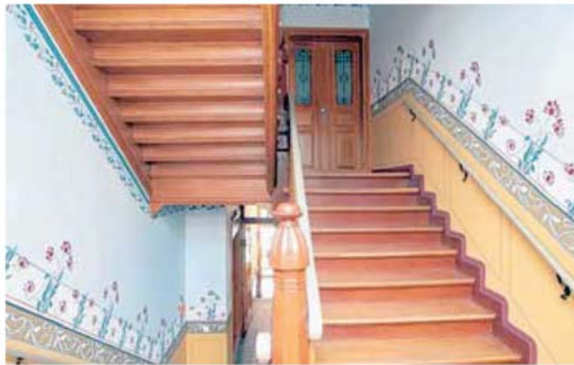
Die Treppenhäuser erhalten nun jene Bemalung zurück, die sie zur Erbauungszeit der Häuser zwischen 1900 und 1910 bekamen.
