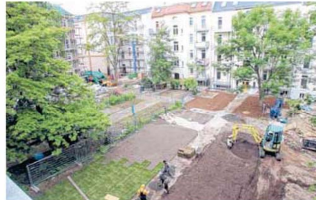
Der Gemeinschaftshof im ersten Karree wird mit Rollrasen begrünt. Hier entsteht noch eine Wasserlandschaft. Fotos: André Kempner
