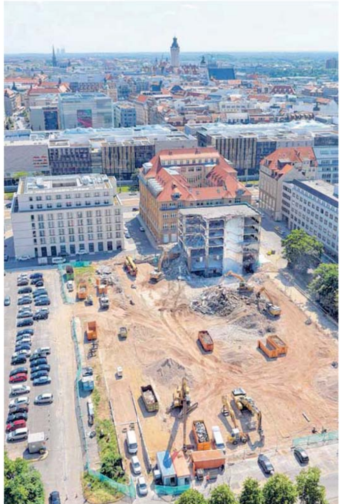
Nur noch ein winziger Rest ist vom ehemaligen Robotron-Haus zwischen Gerber- und Nordstraße übriggeblieben. Die Sächsische Aufbaubank will dort für 40 Millionen Euro ihren Firmensitz für 600 Mitarbeiter errichten. Foto: Wolfgang Zeyen
