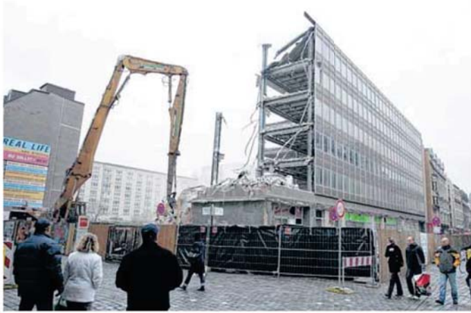
Dem sechsstöckigen Interpelz-Gebäude in der Nikolaistraße schlug vor fünf Jahren schon die letzte Stunde. Heute steht an der Stelle ein Hotelneubau mit 194 Betten. Foto: André Kempner
