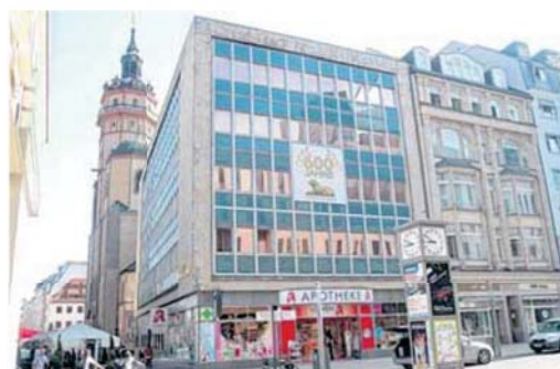
Der markante Stahlskelettbau in der Grimmaischen Straße beherbergt Leipzigs älteste Apotheke. Fotos: André Kempner
